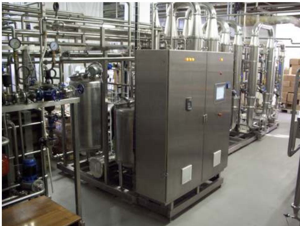
Установка марки "ВОДОПАД МТК 64,5-6-222", 1100 кг творога в час; ОАО "ТМК"; эксплуатируется с 2011г.
