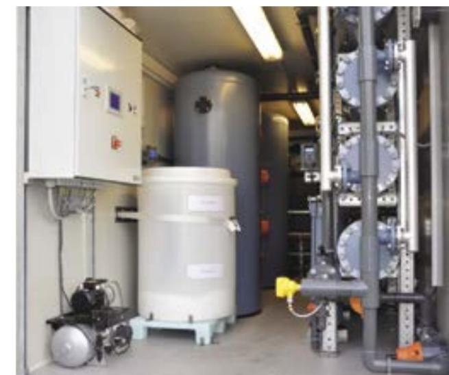
Контейнер 12х2,45 состоящий из напорных фильтров типа TFB 20 для оксидации и фильтрации воды. Станция имеет производительность 90 м³/ч.
